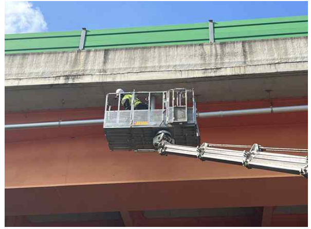
고소점검차를 이용한 근접조사
